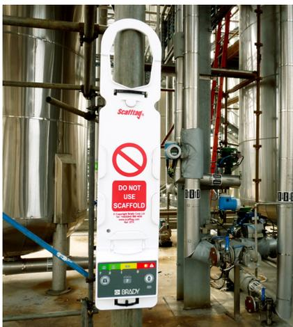
Le minuteur d'inspection d'échafaudage innovant peut aider à sauver des vies en indiquant clairement l'échéance de maintenance sur les étiquettes Scafftags de Brady. Ses voyants LED attirent l'attention des utilisateurs et des professionnels de la maintenance même à distance et permettent d'éviter l'utilisation d'échafaudages non inspectés ou usagés.
